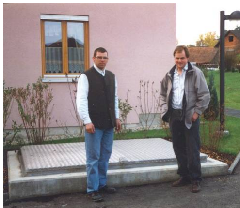
Hackgutbunker seitlich angebaut
