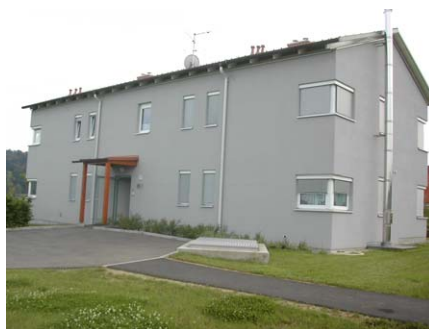
Seitlich angebauter Bunker bzw. Edelstahlkamin
