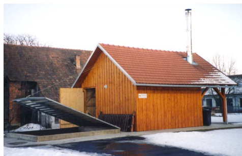
Unterirdischer Heiz- und Lagerraum, Geräteschuppen mit Abgang
