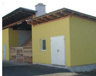
Heizraum mit Brennstofflager
